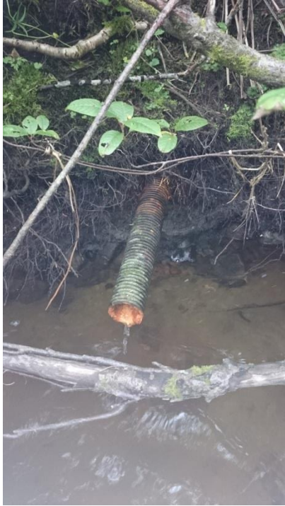
Figur 9 & 10: Ankomande dräneringsrör och betongbrunn från gammal dricksvattenbrun med rinnande vatten och vad som antas vara järnuflällning.
