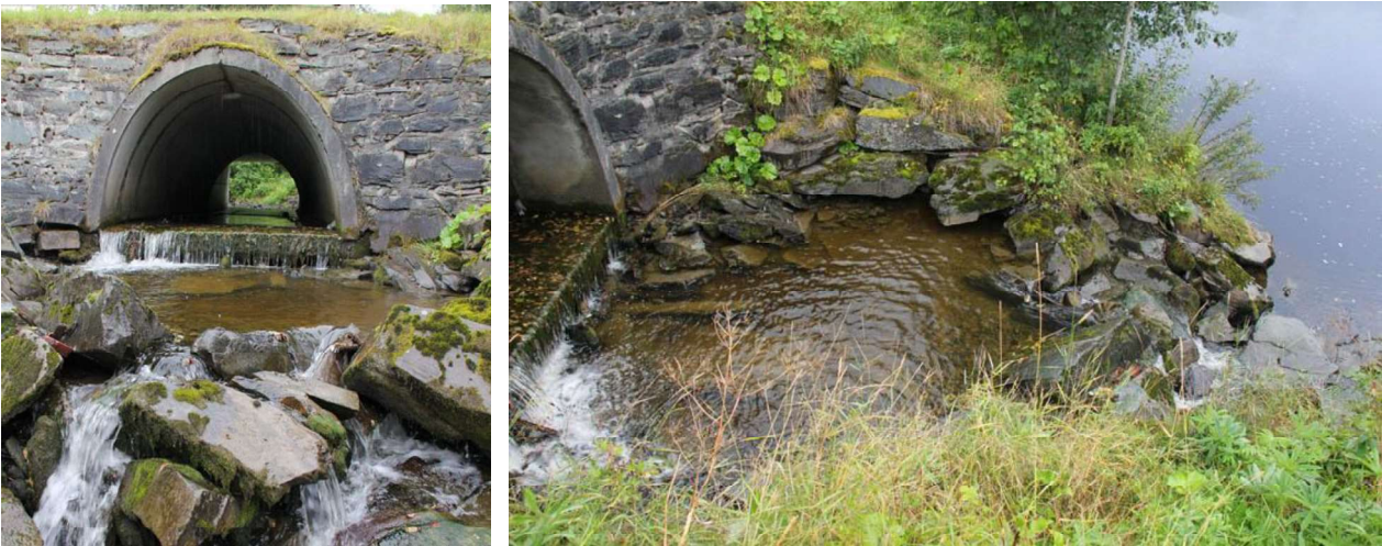
Figur 4. Bildene viser Kvernmobekkens utløp gjennom kulverten, fall ved utløp i kulp og steinsetting ved utløp i Stjørdalselva.
