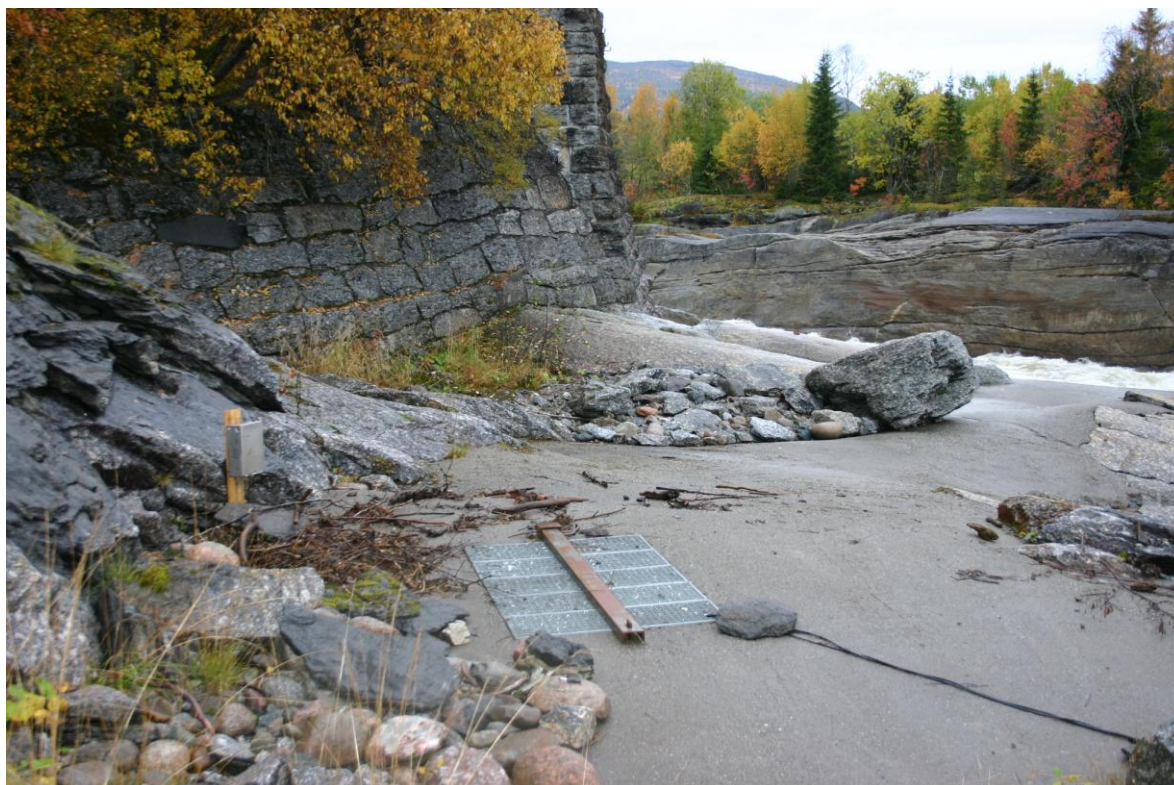
Figur 2. Inspeksjonsluka hvor telleren har fått ny plassering i kulpen under inspeksjonsluka.
