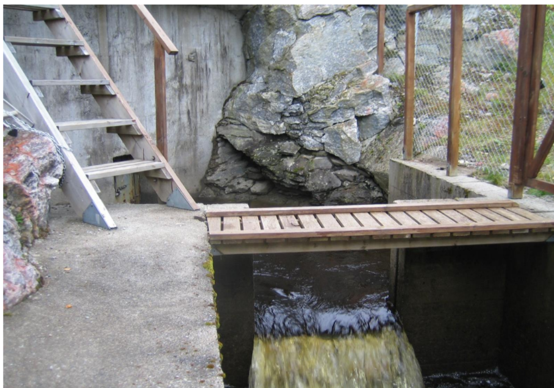
Figur 7. Ny plassering av telleren til øverste kulvert i trappa kan føre til mindre problemer med luftbobler foran videokamera.
