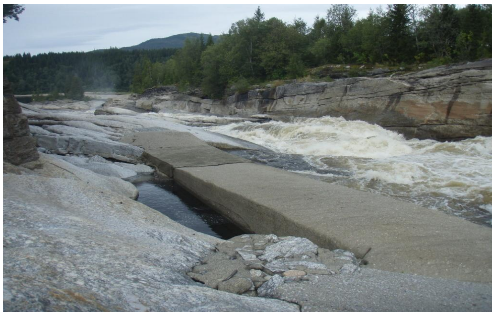
Figur 2. Fisketrappa i Tømmeråsfossen er sprengt ut i fjell og går stedvis lukket.
