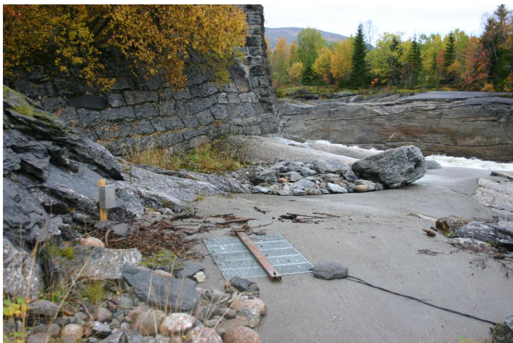
Figur 3. Inspeksjonsluka på bildet viser hvor i fisketrappa i Tømmeråsfossen fisketelleren er plassert.
