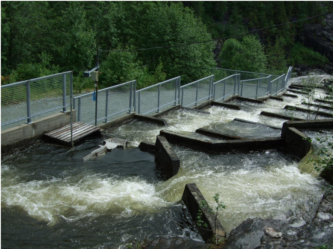
Figur 2: Deler av fisketrappa i Nedre Fiskumfoss. Den mekaniske fisketelleren med videokamera til venstre på bildet. Foto: Karina Moe.
