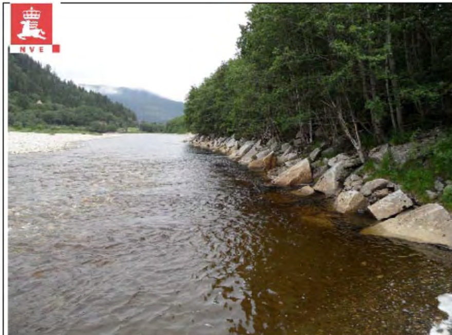
Bilde 1: Forbygning starter først nedstrøms utløp. Sett nedover Gaula, utløpet skimtes til høyre.
