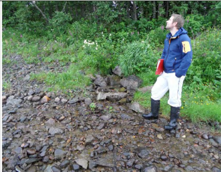
Bilde 2: Utløpet, sett fra Namsen.
