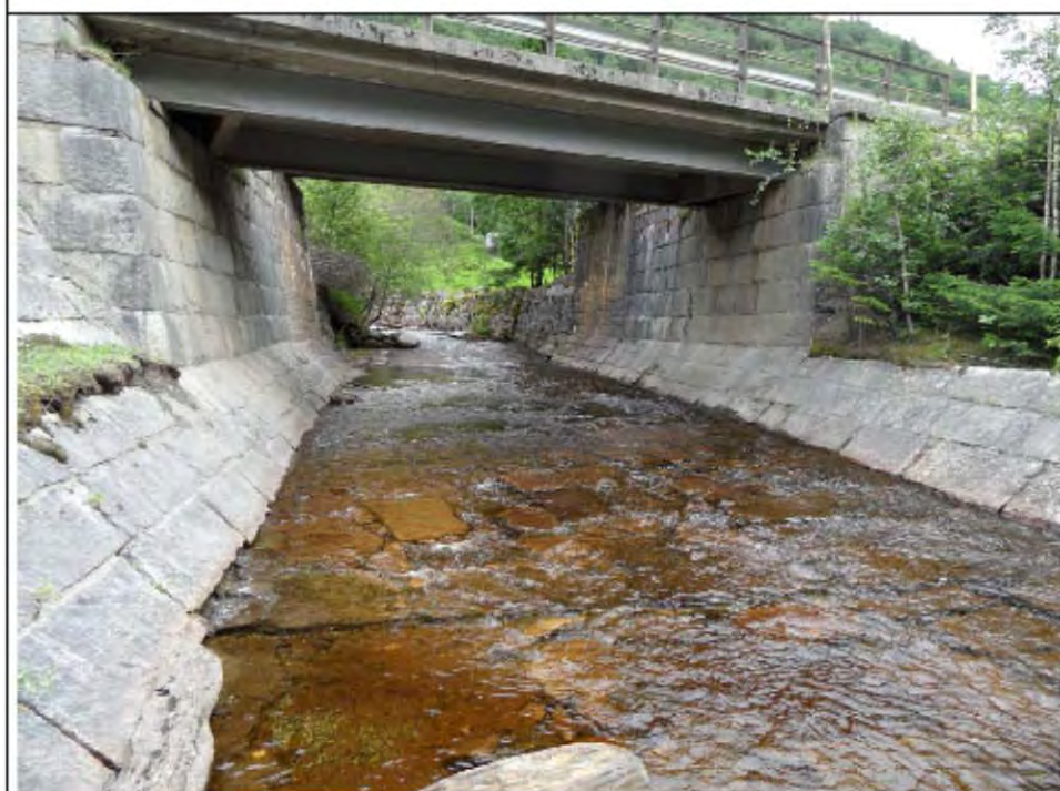
Bilde 2: Kulvert og kanal under veg og jernbanen virker uproblematisk i forhold til oppgang av fisk.
