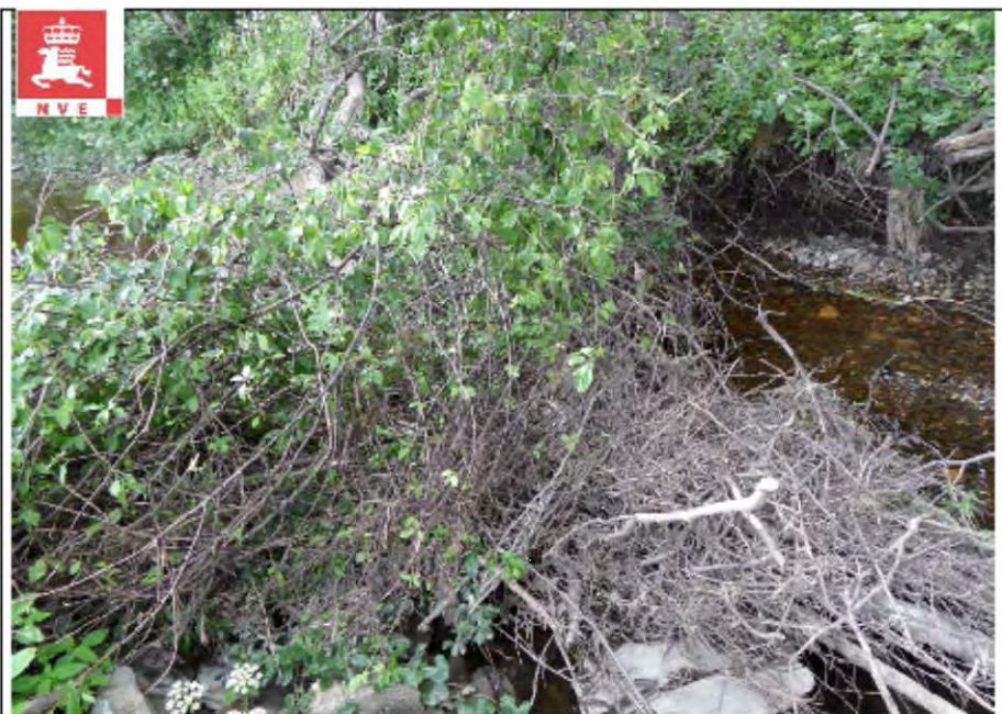
Bilde 1: Store mengder hogstmaterial hadde samlet seg 30m fra utløpet og sperret løpet.
