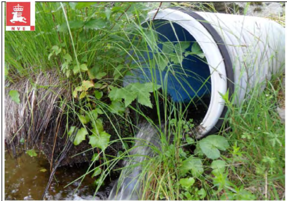
Bilde 1: Utløpet fra bekken renner ut i Namsen gjennom forbygningen i dette røret som er 30cm i diameter.
