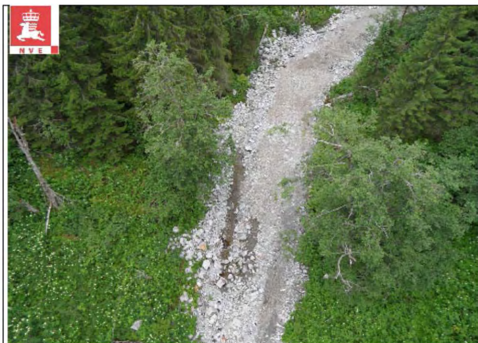
Bilde 1: Bekkefareet bærer preg av at det fortsatt er en anleggsvei
