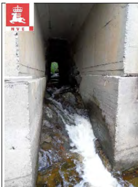
Bilde 1: Utløp fra Gyllbekken i SVV stikkrenne
