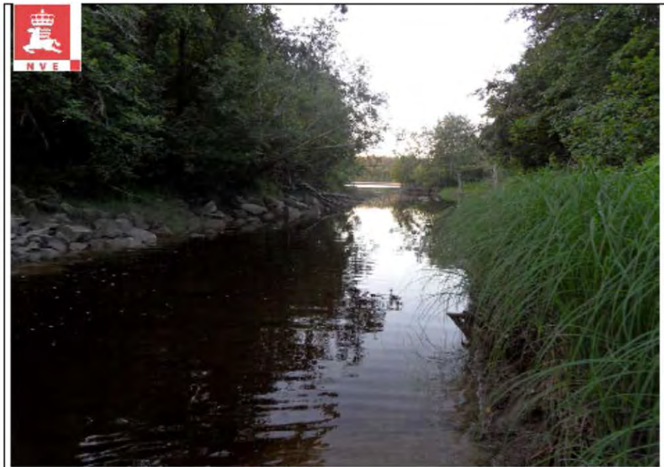
Bilde 1: Forbygningen til NVE ligger parallelt med løpet og hindrer ingen oppgang.
