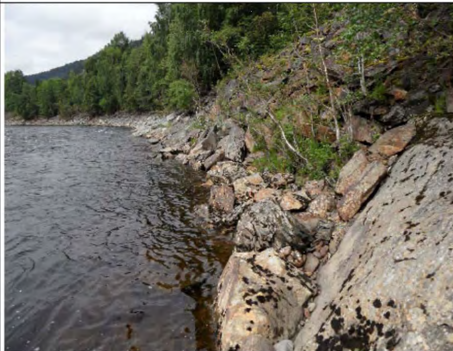
Bilde 2: Forbygningen sett i perspektiv, sett nedstrøms fra utløp.
