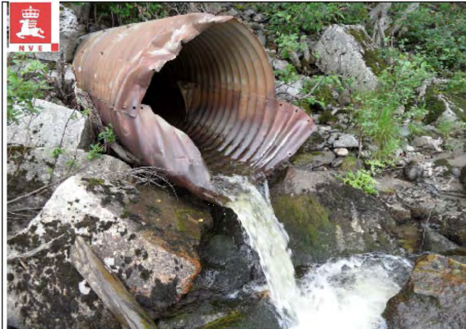
Bilde 1: Utløpet av den 500m rørlagte Spjeldbekken. Spranget opp i kulverten ved aktuell vannføring var muligens 75cm.
