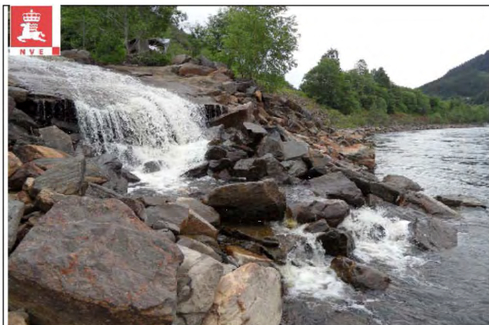
Bilde 1: Vandringshinder i SVV/NVE forbygning.
