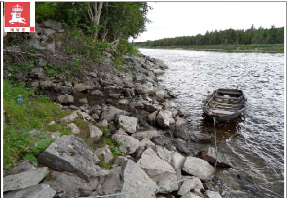
Bilde 1: Svært stor stein ift. vannføring i munningen. Spredt utløp.
