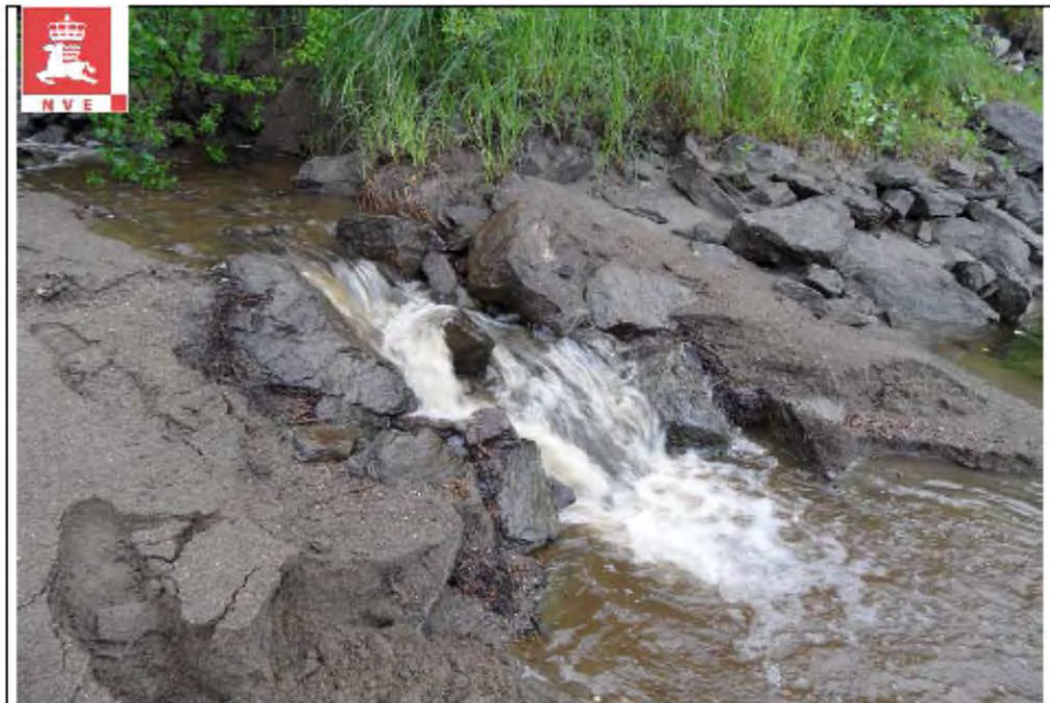
Bilde 1: Brudalsbekken har et sprang i forbygningen som kan være vandringshindrende ved lav vannføring ( 93\text{m}^3\text{s}^{-1} ) i Namsen. Vegetasjonsmål er riktignok høyt og estimerer gir 62cm høyere vannstand i Namsen i gytesesongen.
