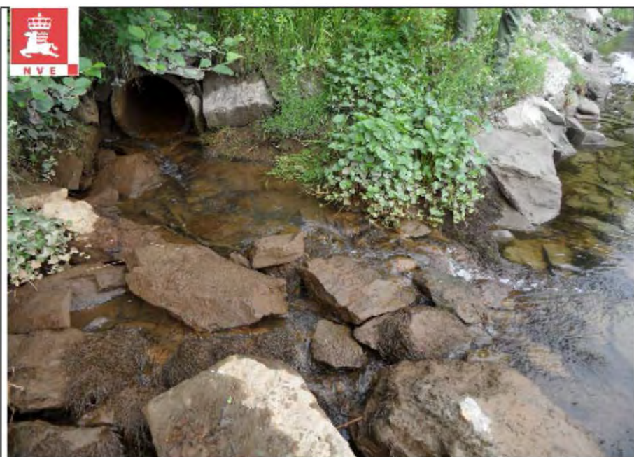
Bilde 4: Utløp av den rørlagte strekningen fra det gamle løpet til byabekken. Store mengder organisk materiale.
