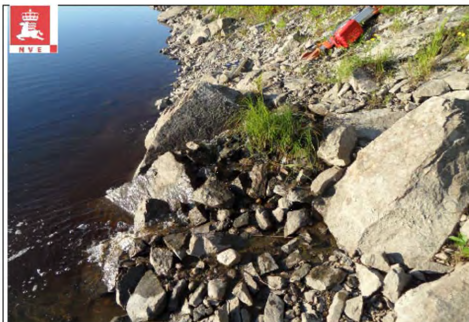
Bilde 1: Bekken renner gjennom forbygningen. Bildet viser faktisk utløp.
