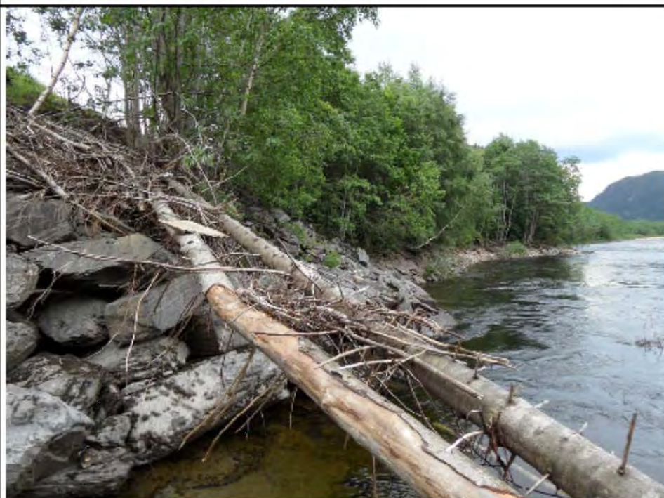
Bilde 2: Forbygningene oppstrøms langs E6. Ingen av disse tilhører NVE ifølge kartet som ble benyttet.
