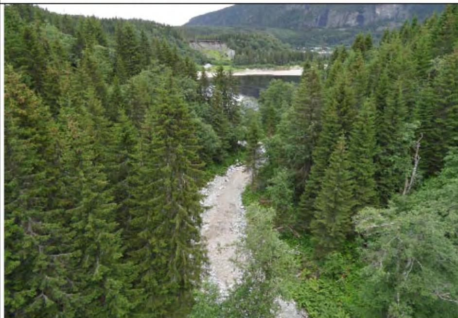
Bilde 2: Anleggsveien sett ned mot den nye forbygningen som er under konstruksjon lenger ned i Tømmeråshøla.
