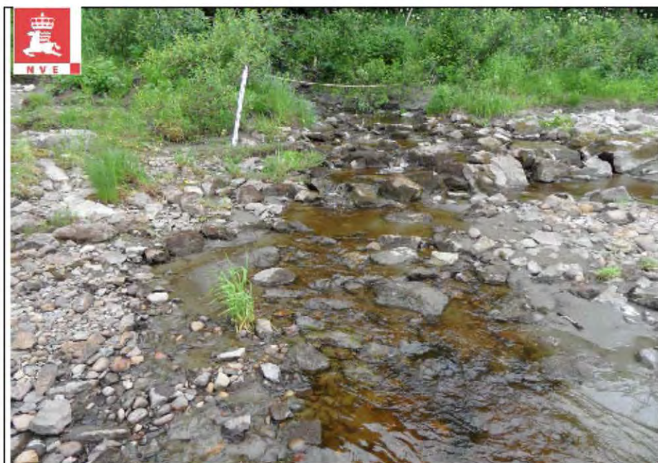
Bilde 3: Liten vannføring, men forbygningen utgjør ikke et problem
