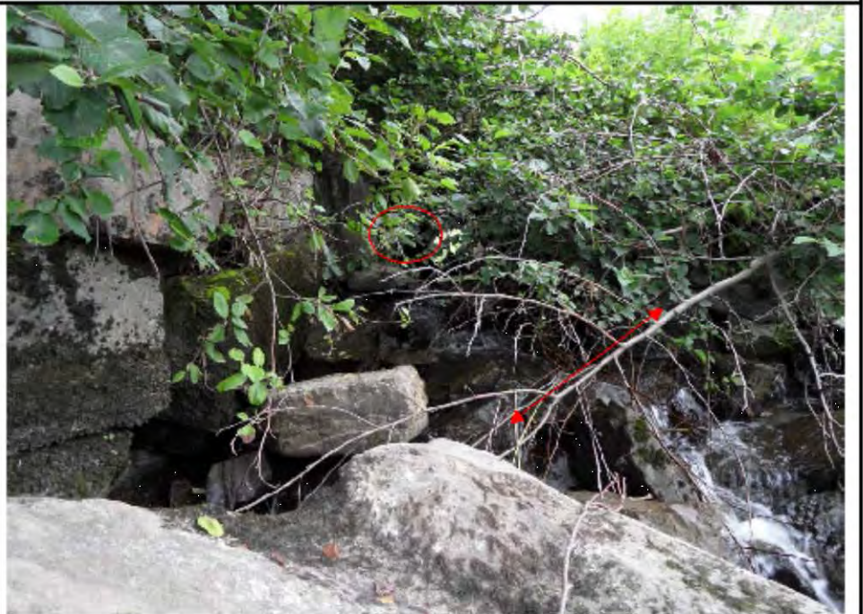
Bilde 2: Ved toppen av bratt parti opp fra elva. Rød linje angir punktet Byabekken setter utfor mot elva. Rød ring angir kulvert, omtrent 5m fra kamera.
