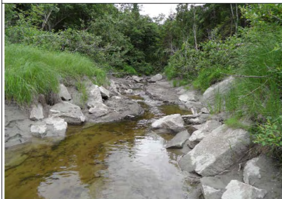
Bilde 2: Forbygningen i området er nesten usynlig i samløpet med Namsen.
