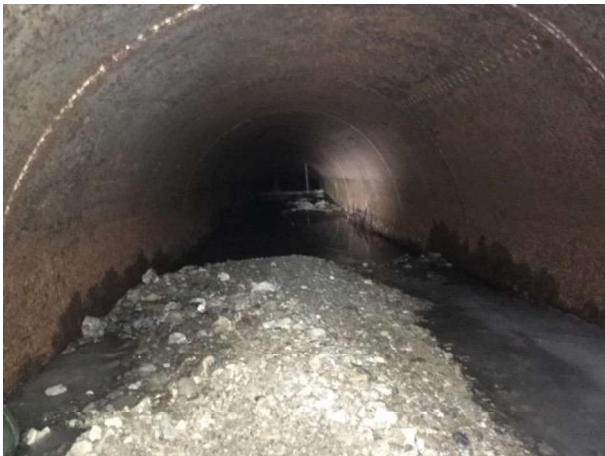
Den 70 meter lange røret øverst i trappa før og etter grusfjerning.
