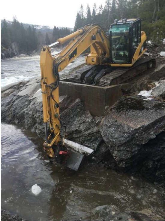
Fjerning av grusmasser ved innløpet til trappa.
