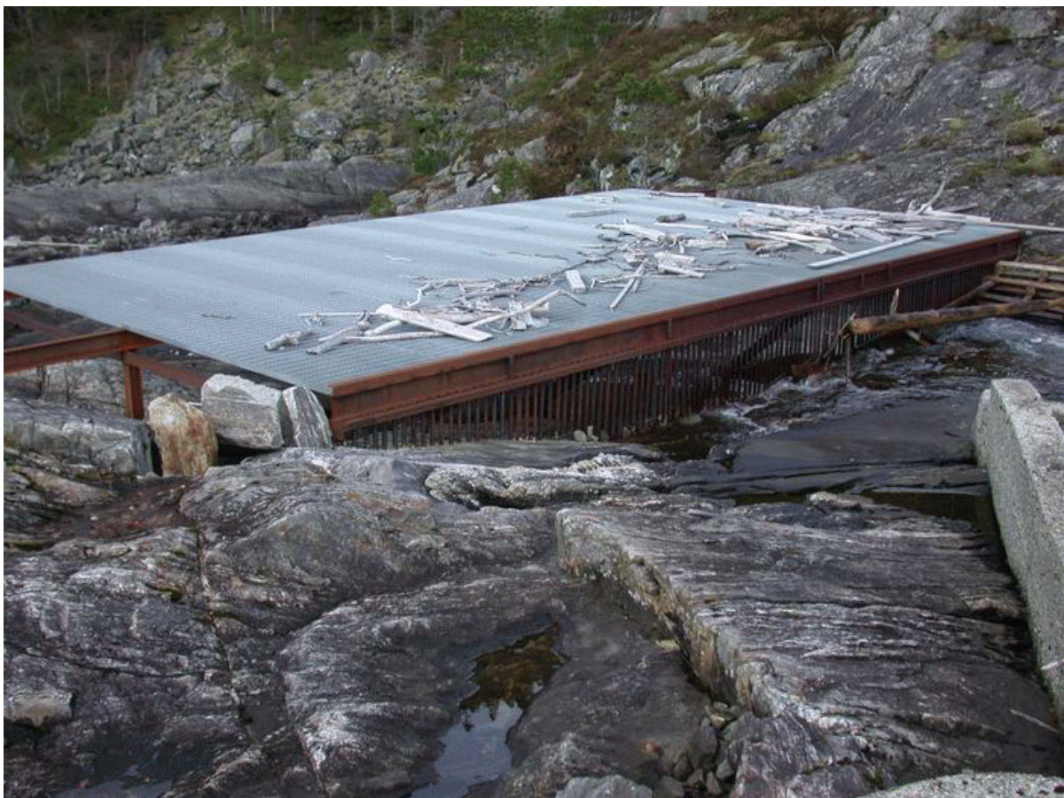
Figur 9. Utløpselven fra Storavatnet ved befaringen høsten 2001 (over) med demningen med det åpne og uberørte overløpet i bakgrunnen, og ved befaringen høsten 2003 (under) med fiskesperren montert i åpningen..
