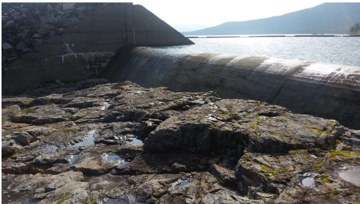
Bilde 5. Overløpsdammen fra Tunnsjøflyan til Tunnsjøelva. Ved overløp og bølgeaktivitet vil ørekyt lett spres nedover i Tunnsjøelva. Foto: Tor G. Heggberget
