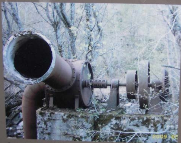
Rester av turbin II
