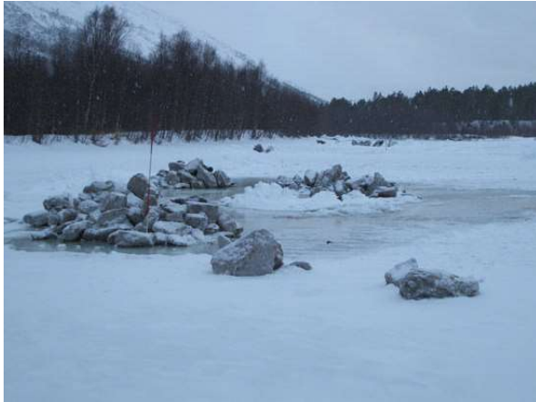
Figur 30. Utlegging av steingrupper og større enkeltstein på isen i et terskelbasseng i Skjoma (Nordland.)
