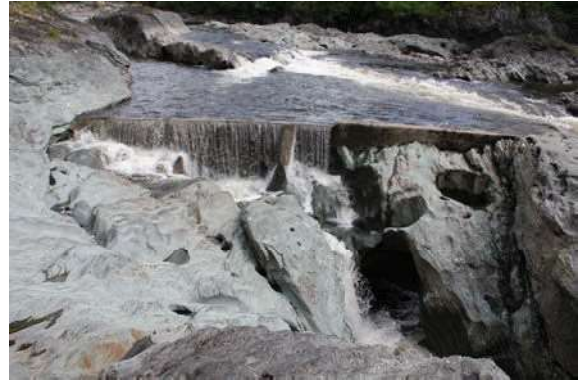
Figur13. Nordre løp, rettkronet betongterskel
