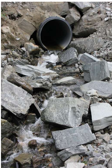
Figur 9. Eksempel på vandringshinder i Follobekken (2012).
