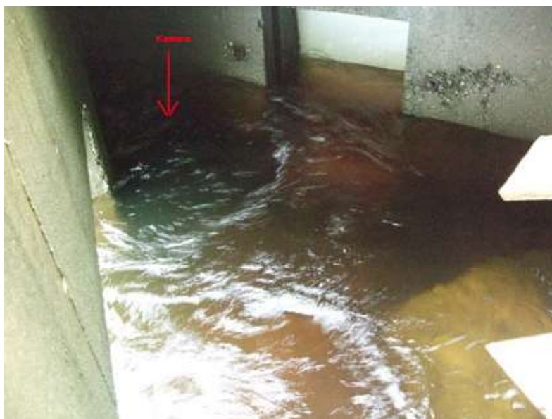
Figur 2. Plassering av kamera markert med rød pil. All fisk må passere gjennom åpningen øverst i bildet.
