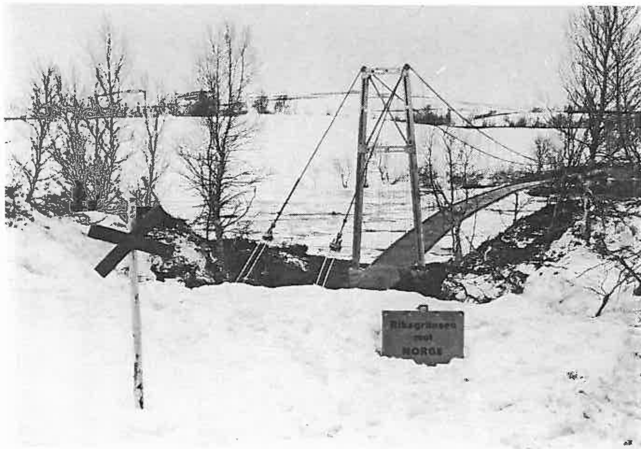
Fig. 1. Den nye hengebroen over Enan, et svensk/norsk samarbeidsprosjekt i 1984. Foto: Adresseavisen.
